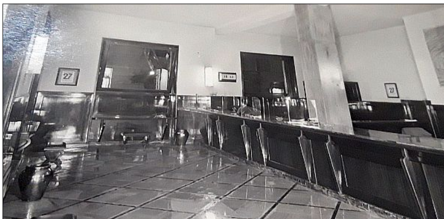
Sala sportelli della sede centrale
